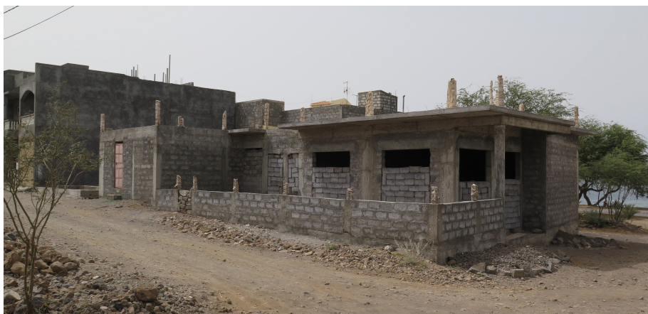
FIGURA 61.2: CONSTRUÇÃO EM ESTRUTURAS DE BETÃO E BLOCOS DE CIMENTO, ILHA DE SANTO ANTÃO. FONTE: ONU-HABITAT
