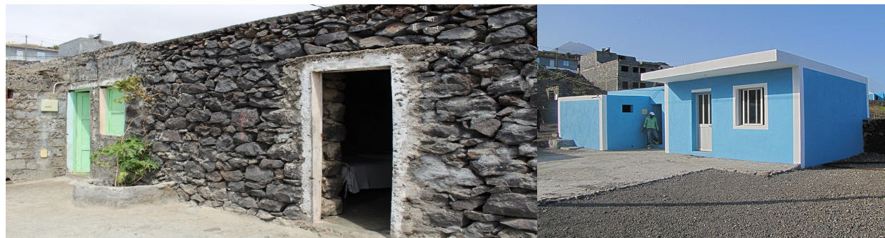
FIGURA 15.2: HABITAÇÃO REABILITADA COMO PARTE DO PRRA, ANTES E DEPOIS. FONTE: MIOTH
