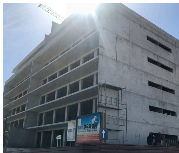
FIGURA 65.6. EDIFÍCIO DE APARTAMENTOS EM CONSTRUÇÃO. FONTE: MIOTH
