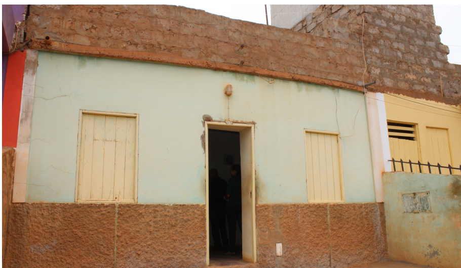
FIGURA 61.3. CONSTRUÇÃO MISTA, INCLUINDO PEDRAS E BLOCOS, ILHA DE SÃO VICENTE. FONTE: ONU-HABITAT
