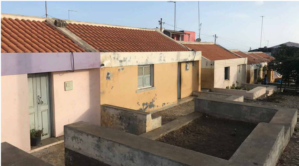
FIGURA 22. CONJUNTO HABITACIONAL EM COOPERAÇÃO COM LUXEMBURGO EM SÃO FILIPE, ILHA DO FOGO
