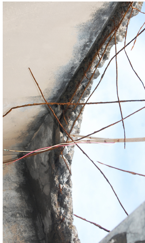
FIGURA 25.2. CONDIÇÕES DE TETO DO TIPO LAJE DE BETÃO. FONTE: MIOTH
