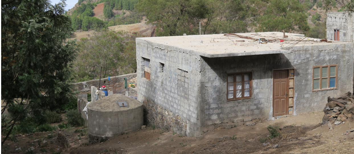
FIGURA 68. COLETA E ARMAZENAMENTO DE ÁGUA PLUVIAL, ILHA DE SANTO ANTÃO
