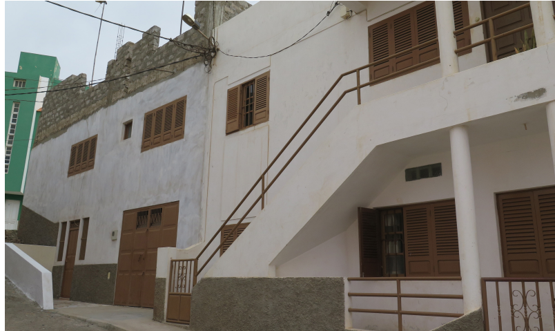
FIGURA 63.1. MORADIA EM CONSTRUÇÃO EVOLUTIVA COM ESCADA EXTERNA COM ACESSO SEPARADO PARA O SEGUNDO PISO, ESPARGOS, ILHA DO SAL. FONTE: ONU-HABITAT
