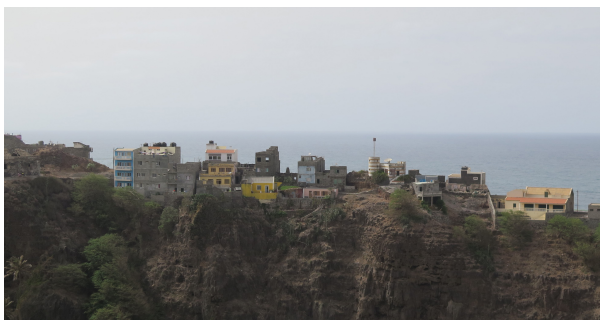
FIGURA 43.2. CONSTRUÇÃO EM TERRENO ACIDENTADO NA RIBEIRA GRANDE, ILHA DE SANTO ANTÃO. FONTE: ONU-HABITAT
