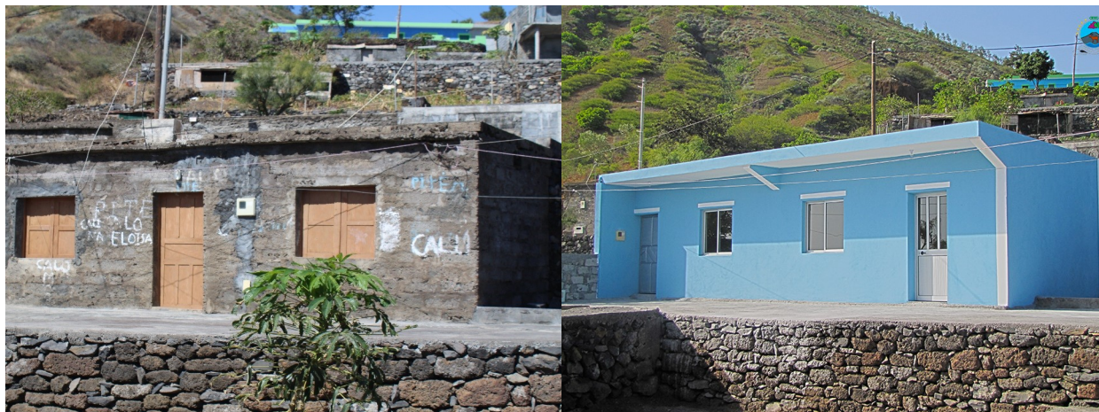
FIGURA 15.1. HABITAÇÃO REABILITADA COMO PARTE DO PRRA, ANTES E DEPOIS. FONTE: MIOTH
