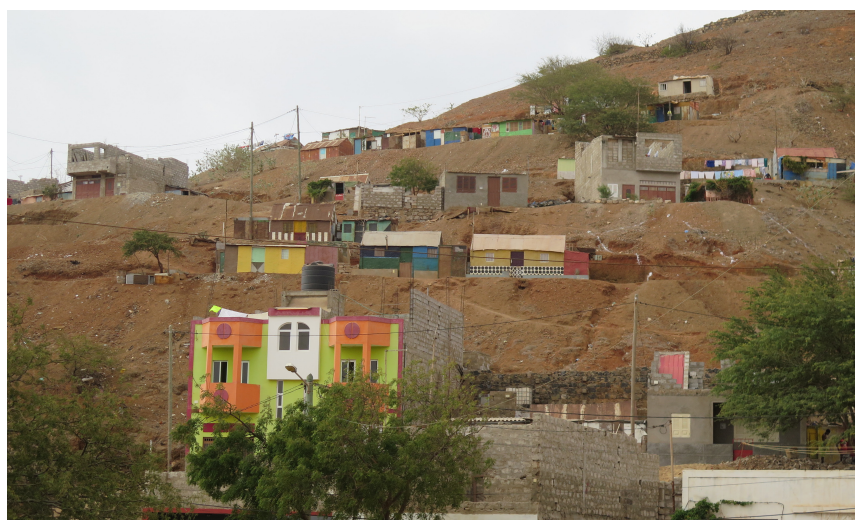
FIGURA 45.2. ACESSO EM ÁREA INFORMAL ACIDENTADA, MINDELO, ILHA DE SÃO VICENTE. FONTE: ONU-HABITAT
