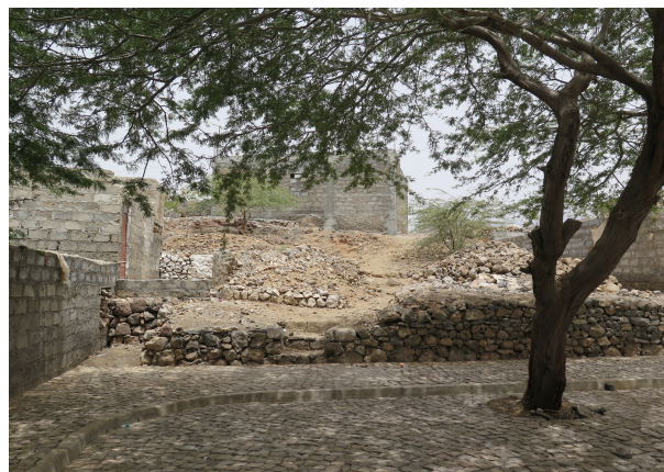
FIGURA 70. USO DE PEDRAS PARA DIMINUIR EROSÃO, PORTO NOVO, ILHA DE SANTO ANTÃO
