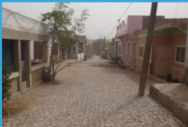
FIGURA 18. REQUALIFICAÇÃO DE FIGUEIRAS, ILHA DE MAIO
