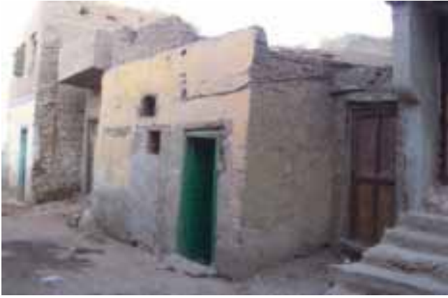
شكل (٢٤) المباني الرديئة بالمدينة
