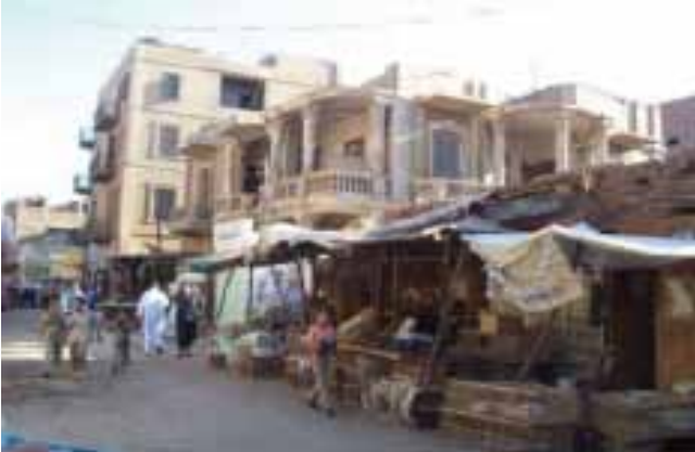
شكل (٢٩) حالات المباني المختلفة بالمدينة
