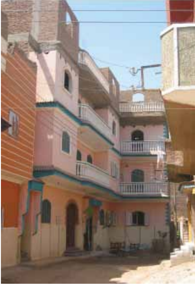
شكل (٣٥) حالات المباني الجيدة بالمدينة
