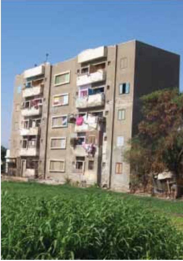
شكل (٢٦) حالات المباني المختلفة بالمدينة
