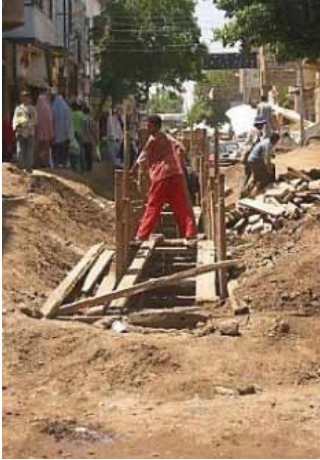
شكل (١٧) مشروع الصرف الصحي الجاري تنفيذه بالمدينة
