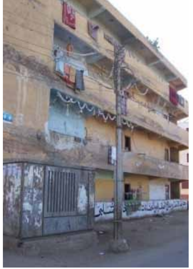
شكل (٢٧) حالات المباني المختلفة بالمدينة
