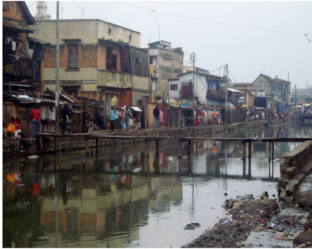
La précarité du réseau d'assainissement et la mauvaise gestion des déchets solides entraînent une pollution du milieu urbain.
