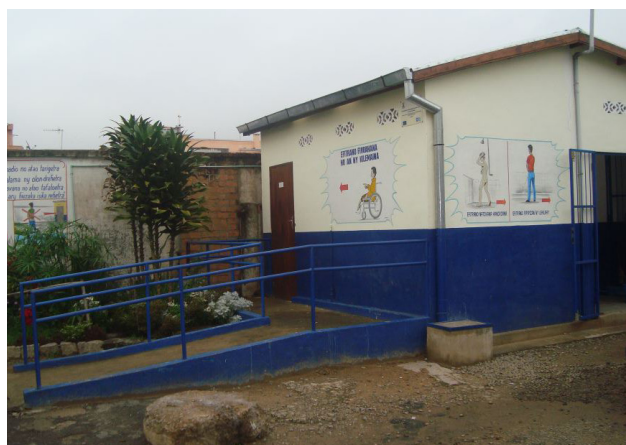
Toilettes et douches publiques accessibles aux fauteuils roulants.
