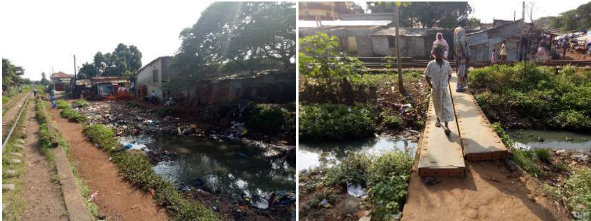
Figure 29 : Vue sur les servitudes de rails de Dixinn en partie inondées
