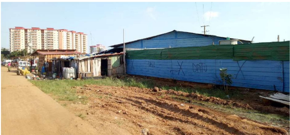
Figure 34 : Vue sur des occupations illégales de servitudes à Kaloum
