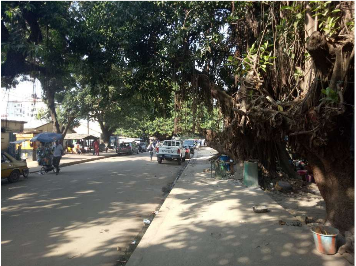
Vue sur la rue avant piétonisation
